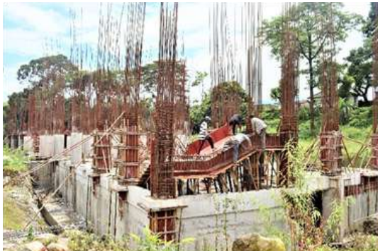
प्रतिष्ठानको निर्माणाधिन भवन
